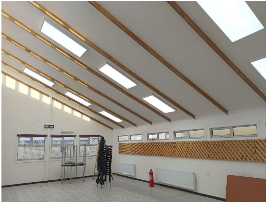
Conservación Sede Comunitaria, Cerro Sombrero, Comuna de Primavera M$ 61.488.-
