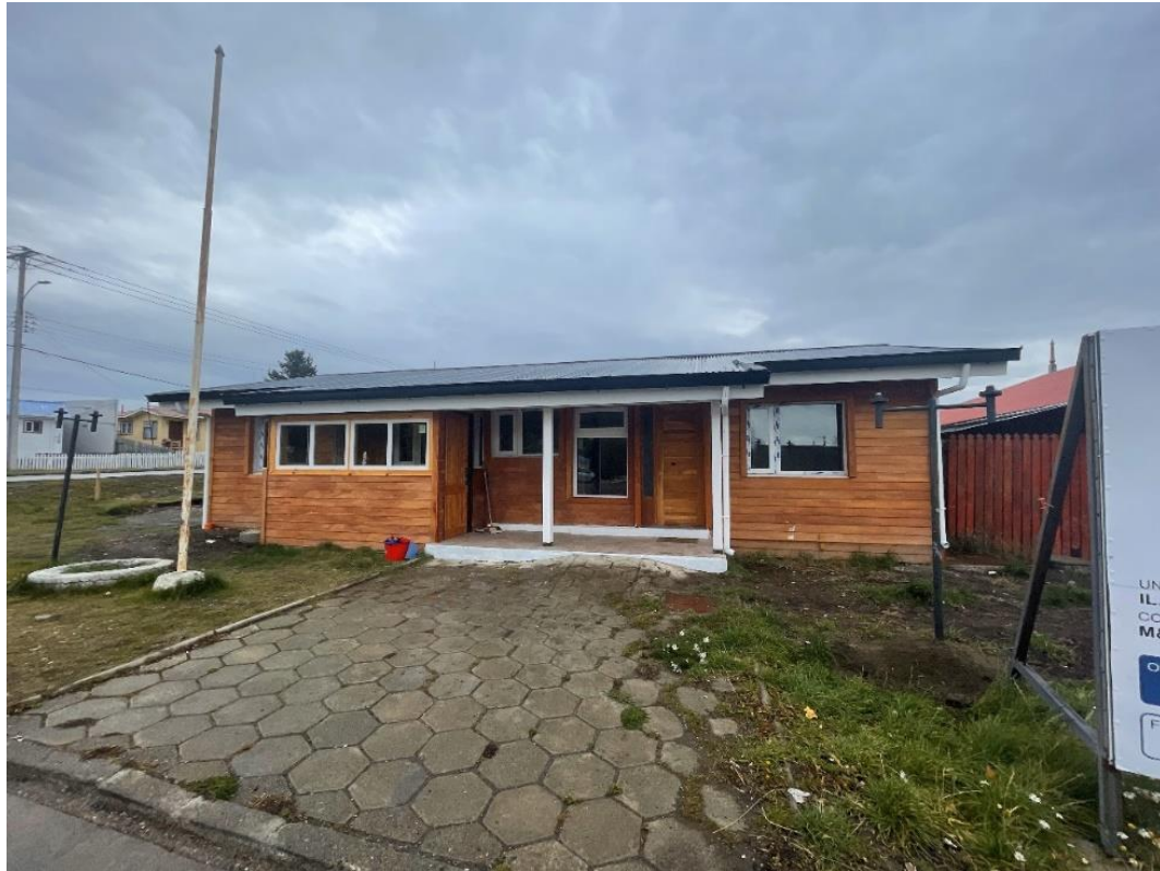
Conservación y Remodelación Ex Posta Villa Tehuelches para Fines Habitacionales M$ 14.952.-
